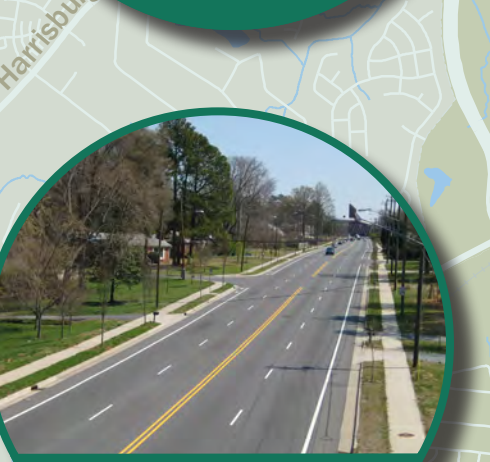
Hickory Grove Rd
